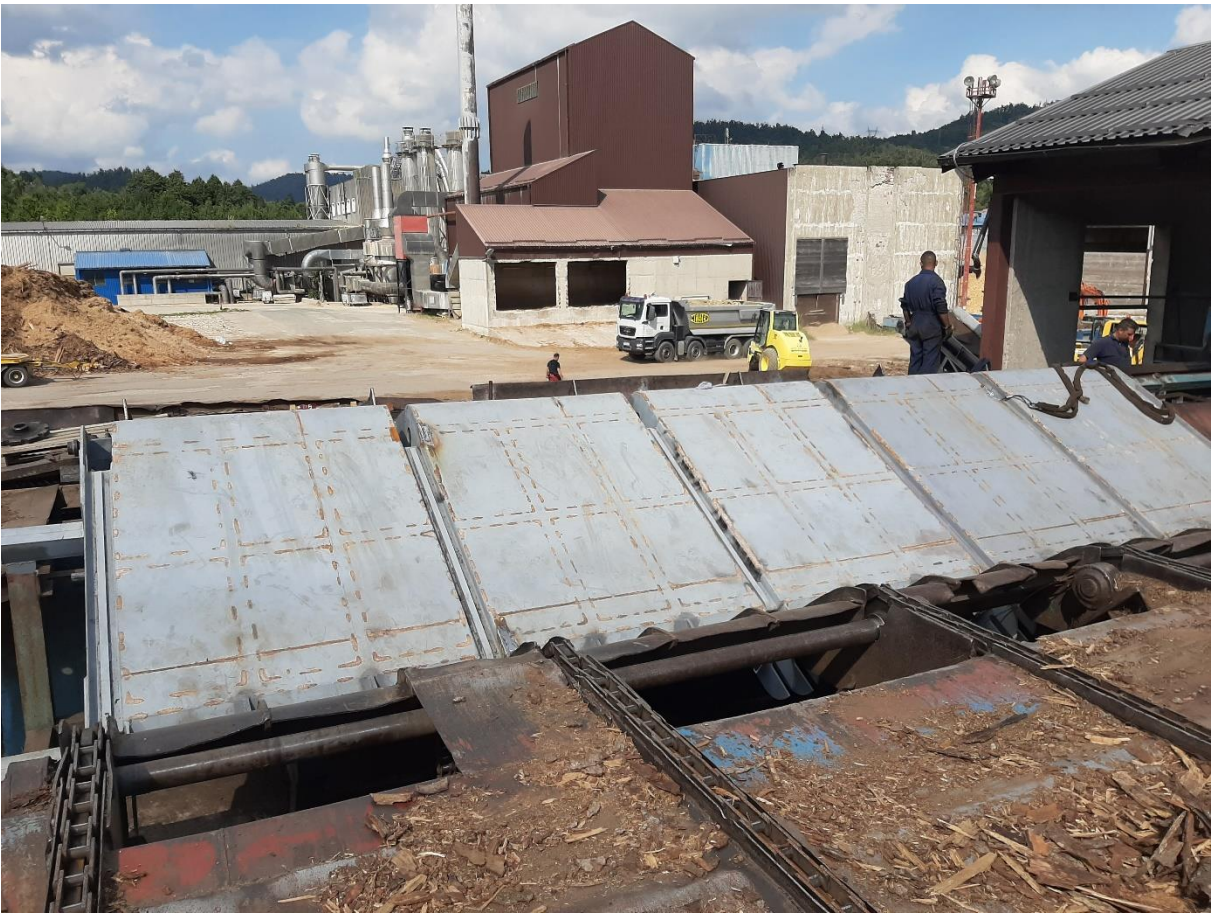
Izmjena, montaža i zavarivanje kosog transportera trupaca
