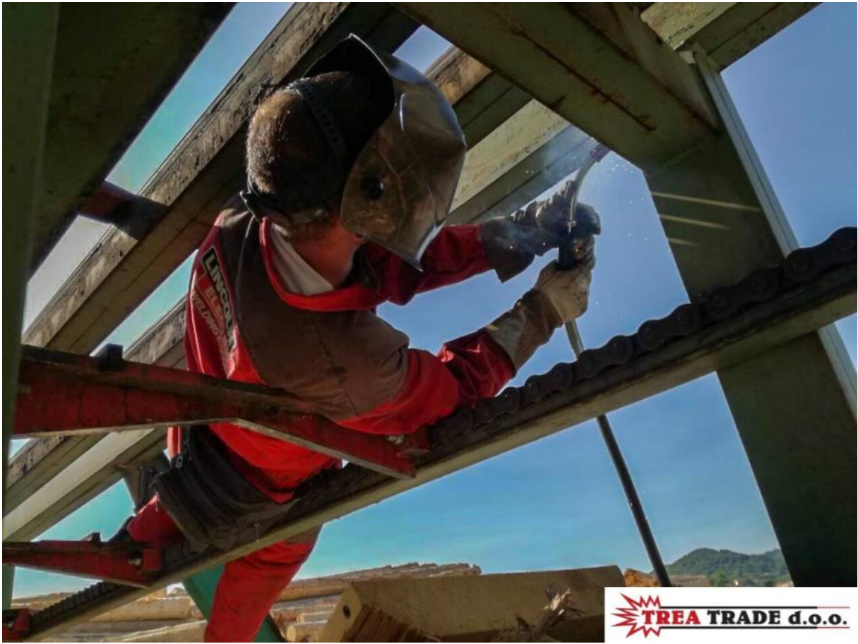
Navarivanje papuča transportera broncom radi smanjenja koeficijenta trenja, zavarivanje konstrukcije transportera
