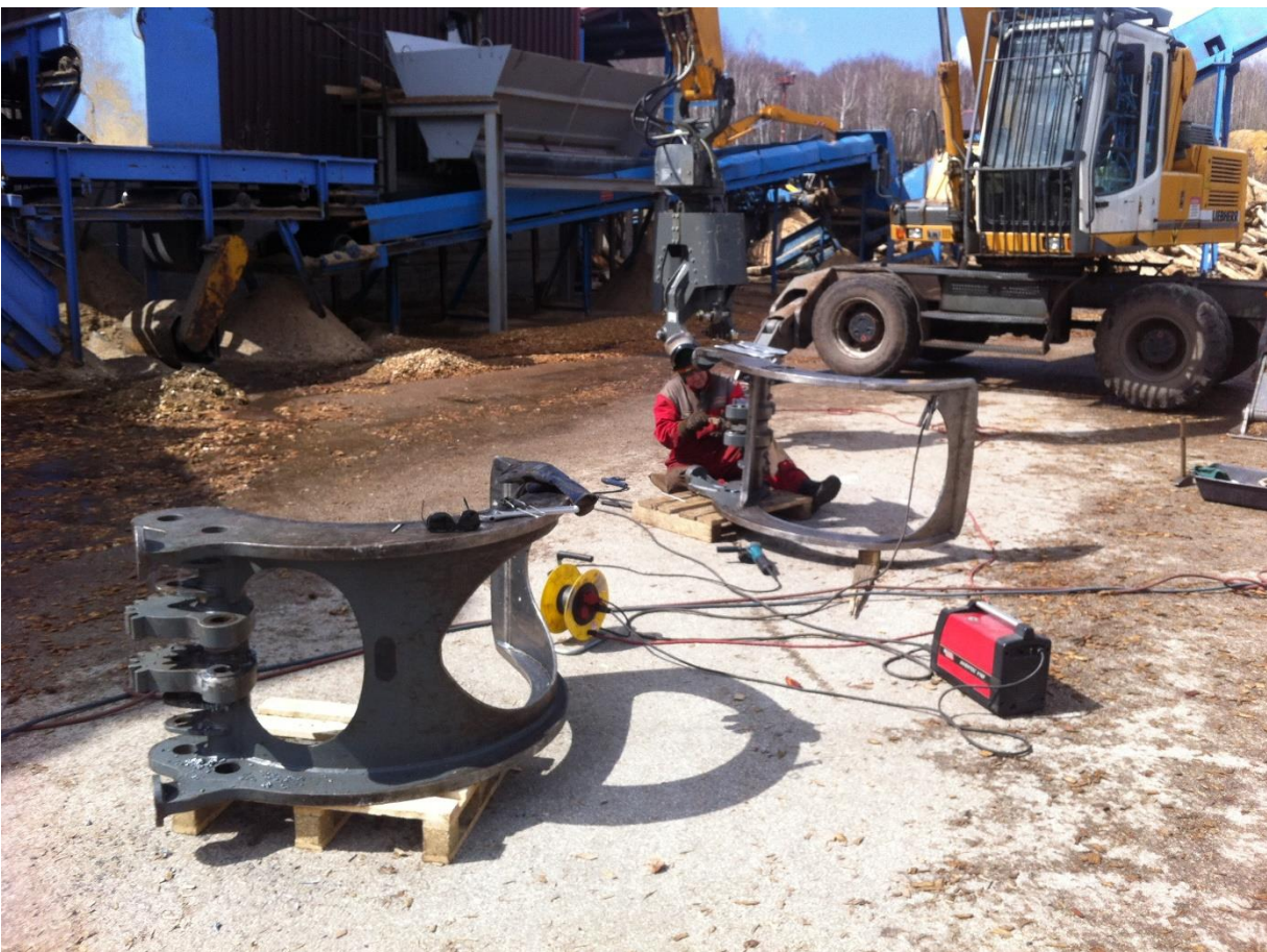
Sanacija pukotina na čeljustima grajfera
