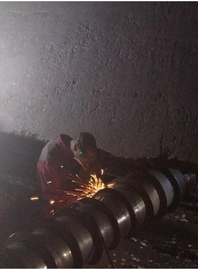
Sanacija oštećenja pužnog transportera sječke
